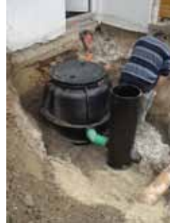
5.) Probenahmeschacht setzen und anschließen
