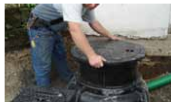
8a.) TOPATEC Teleskopschachtaufsatz einsetzen (bis Klasse B125)
