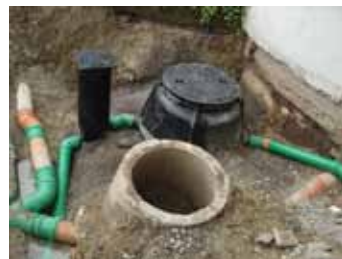
6.) Abwasserrohr wasserdicht anschließen
