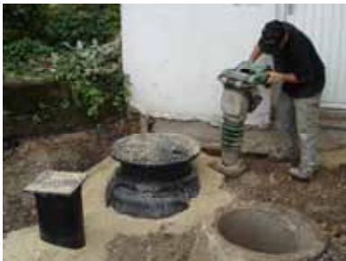
11.) ...Grube Verfüllen und Verdichten
