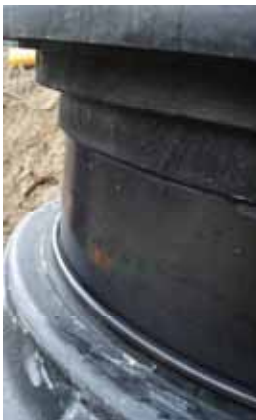
10.) Rollringdichtung nach unten bis zur Lippendichtung schieben (Schmutzschutz für Lippendichtung)
