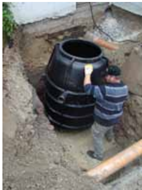
2.) Fettabscheider einsetzen
