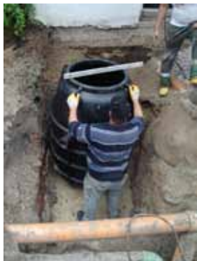
3.) Fettabscheider ausrichten
