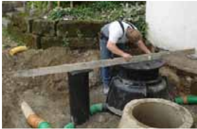
9.) Ausrichten und Abscheideranlage vor dem Befüllen auf Dichtigkeit überprüfen
