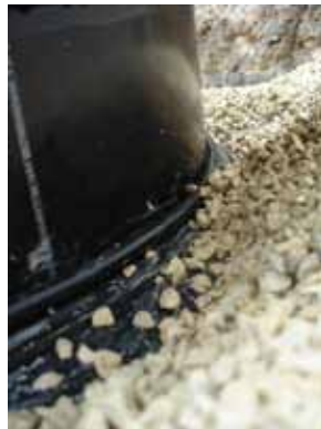
10.) Rollringdichtung nach unten bis zur Lippendichtung schieben (Schmutzschutz für Lippendichtung)
